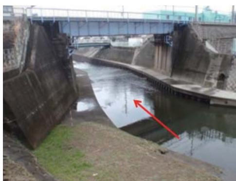
境川相鉄狭窄部（横浜市瀬谷区・大和市）の整備 矢印方向が下流
